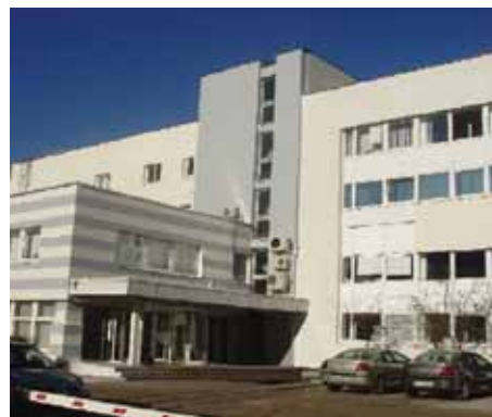
Фасад после утепления
