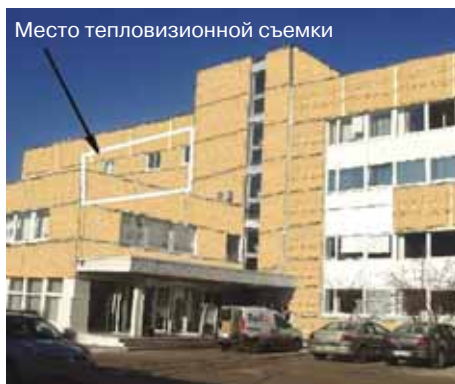
Фасад до утепления
